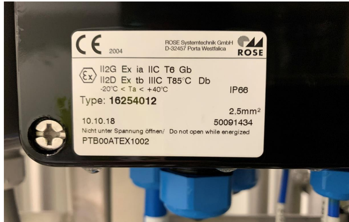
Afbeelding 11: een explosie veilige klemmenkast
